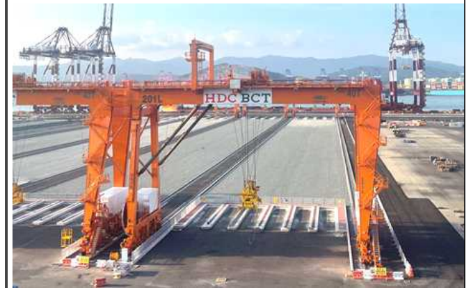
야드 크레인 (TC : Transfer Crane) (32기)
