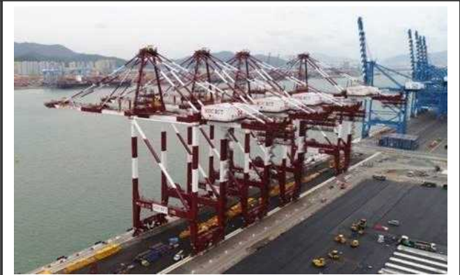
안벽 크레인 (C/C : Container Crane) (8기)
