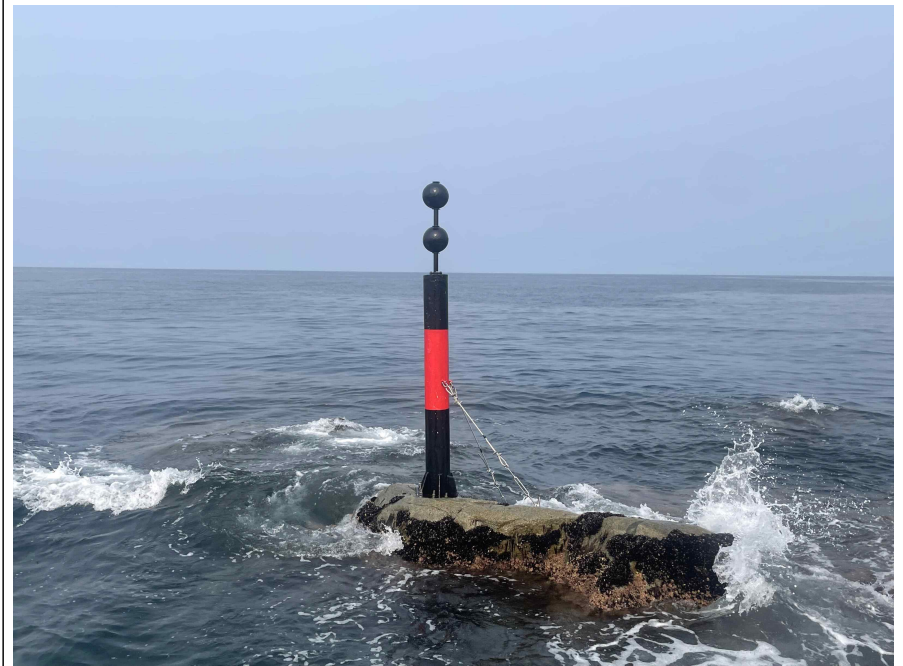
항로표지 설치 전경(높이 2m, 폭 0.2m)
