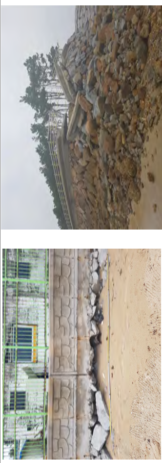
[그림 부록-7] 기초부 사면변화 및 피복석 유실
