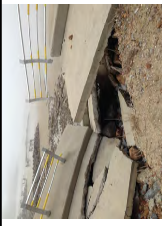
[그림 부록-2] 상치콘크리트 경사/전도로 인한 파괴가 발생한 사례
