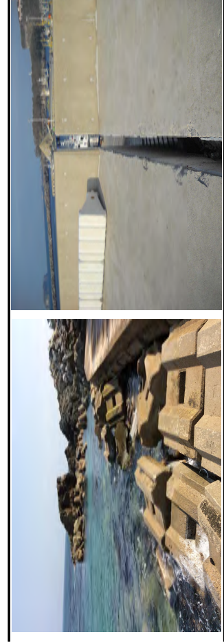
[그림 부록-3] 근교블록의 이동 및 이격이 발생한 사례
